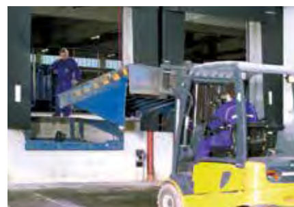
Oude docklevellers uitbouwen, eventueel put aanpassen (bijv. met montageplaten of consoles)
