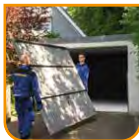
Demontage en milieuvriendelijke verwijdering
