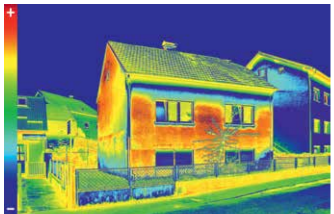
Thermografische opname van een woonhuis
