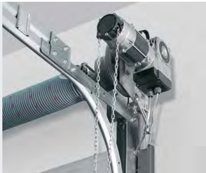
Standaard montagepositie horizontaal, als alternatief verticaal, afbeelding met optionele noodhandketting
