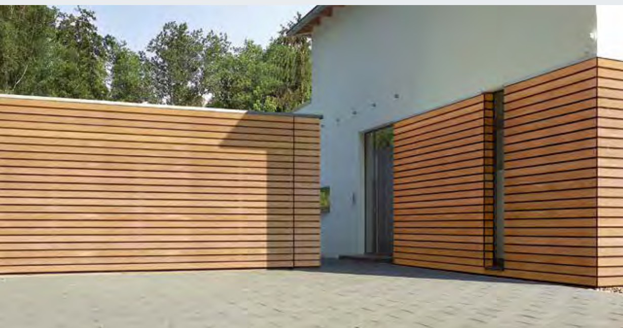
Bekleding door klant met houten panelen
