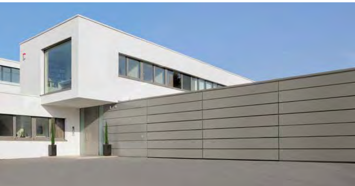
Bekleding door de klant met aluminium sandwichplaten
